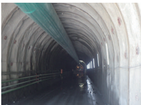
各種工事照明 トンネル工事等
